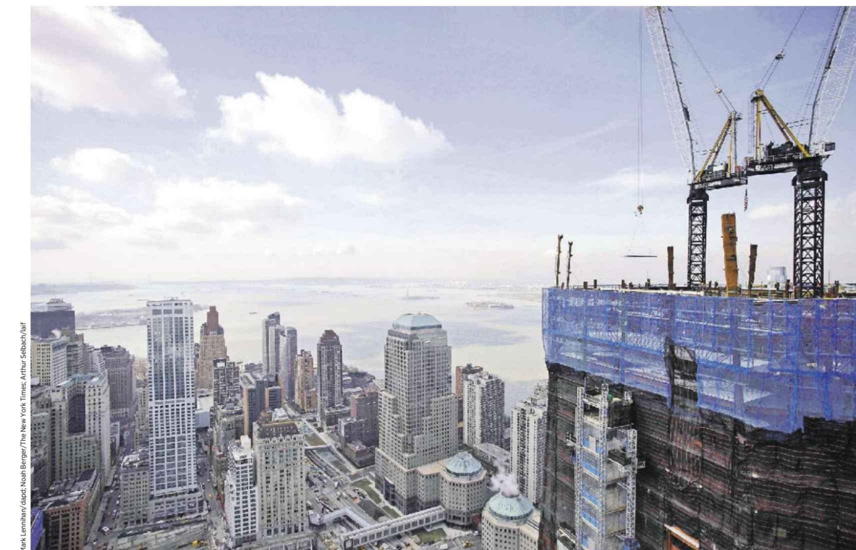
Baustelle Ground Zero: Bis zum 58. Stock ist der „Freedom Tower“ in New York bereits fertiggebaut.
