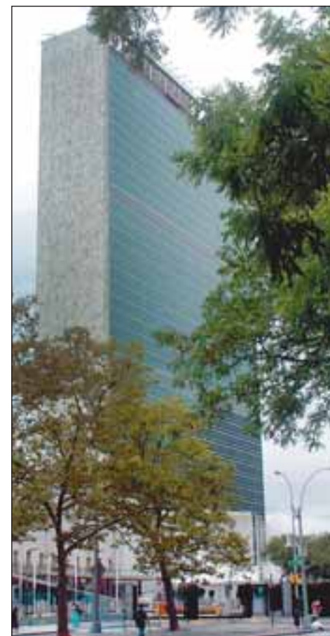
Weltweit im Blickpunkt: Das Gebäude der Vereinten Nationen am Ufer des East River in New York. Fotos: Heribert Vogt
